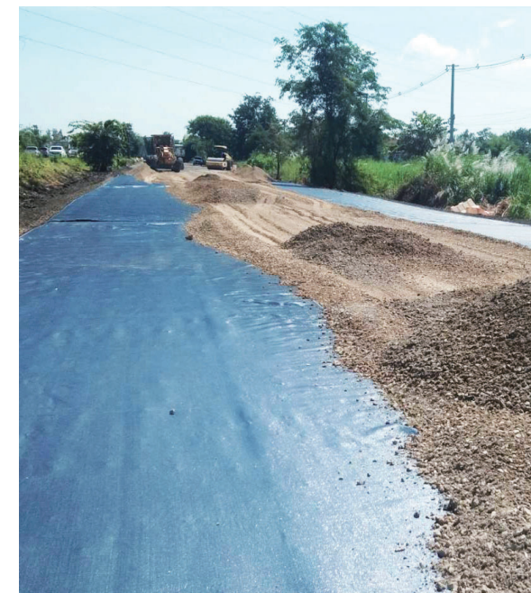
膨胀粘土路基的路面修复
